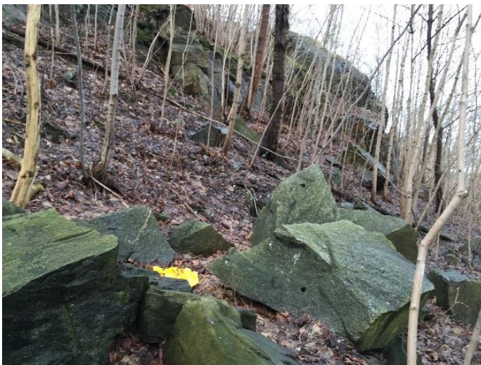
Figur 3 Lösa bergblock från tidigare sprängningar i det flacka avsnittet av slänten.
