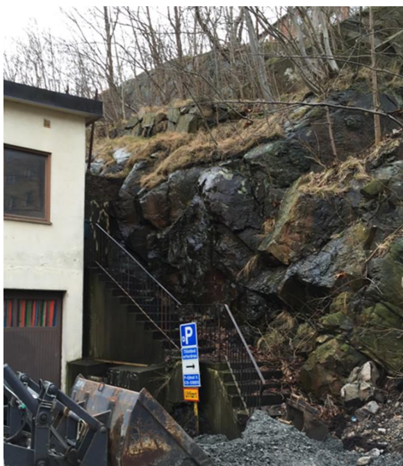
Figur 6 Bergets kvalitet vid nedre delen av slänten. En sprickzon som stupar in i berget syns över trappan.
